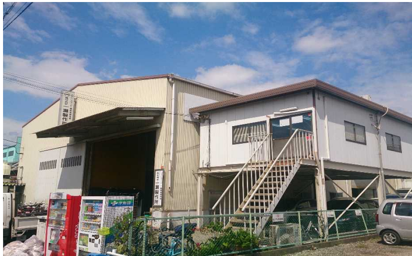
《工場外観;左が機械場》
